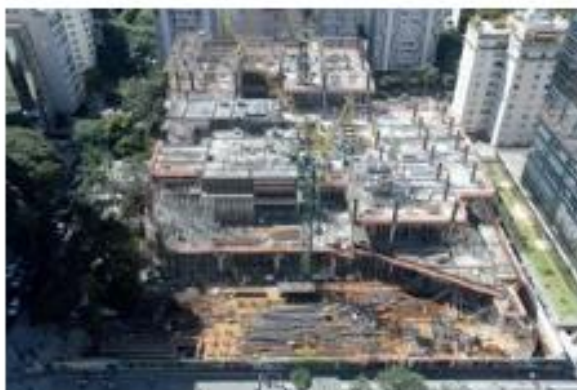
Logística complexa condicionou uso de estrutura em concreto armado moldado in loco
