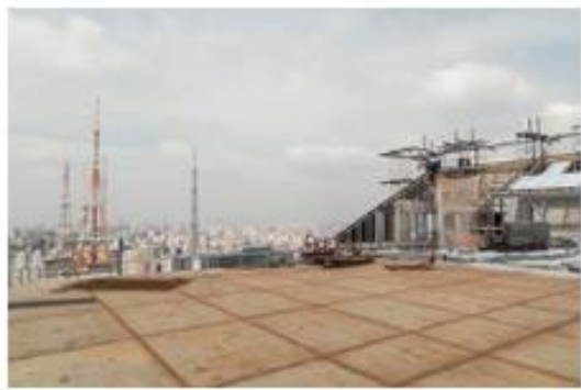
Heliponto em balanço foi executado em estrutura metálica fixada com Insertos especiais à estrutura de concreto
