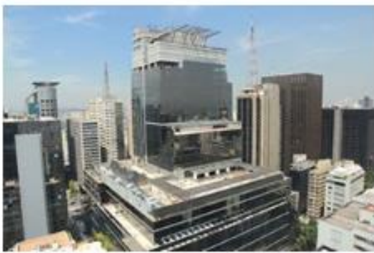
Heliponto em balanço foi executado em estrutura metálica fixada com Insertos especiais à estrutura de concreto
