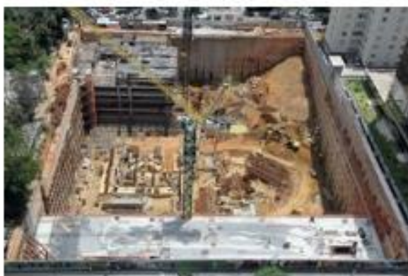
Escavações a 30 m de profundidade e proximidade da Linha Verde do Metrô foram os principais desafios do projeto e execução das fundações
