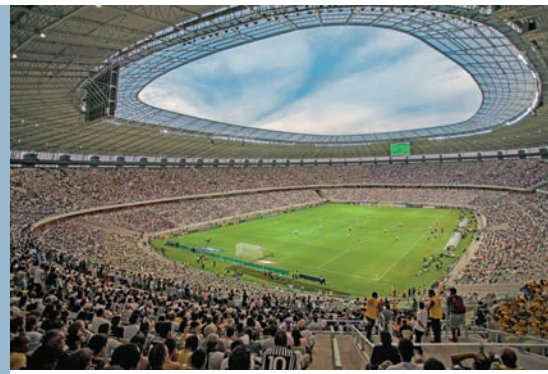
Reforma, ampliação e modernização da Arena Castelão, realizadas pela Galvão Engenharia.
