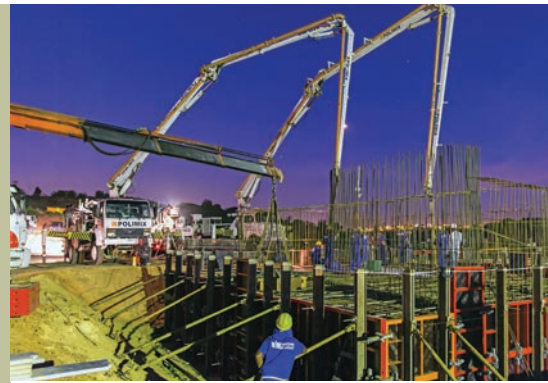
Concretagem dos blocos de fundação da ponte estaiada de Hortolândia (SP), uma obra da Paulítec, que transpõe o reservatório de amortecimento de cheias da cidade.
