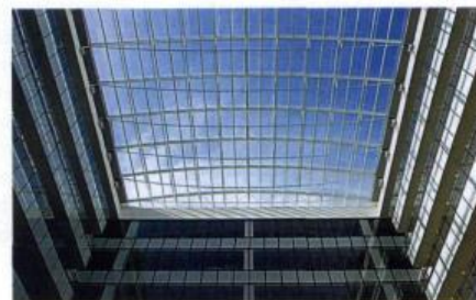
▲ Edifício Cidade Nova, no Rio de Janeiro: claraboia com 900m 2 protegida por persianas motorizadas
