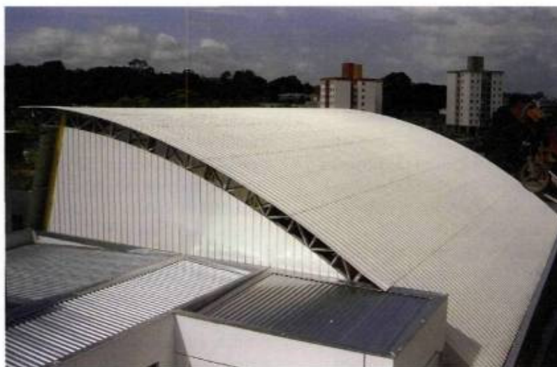
Telhas simples de aço ou alumínio são muito utilizadas em coberturas convencionais em função do baixo custo, porém, não apresentam isolamento termoacústico
