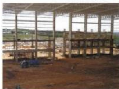
Visão interna do hangar na fase de montagem da cobertura
