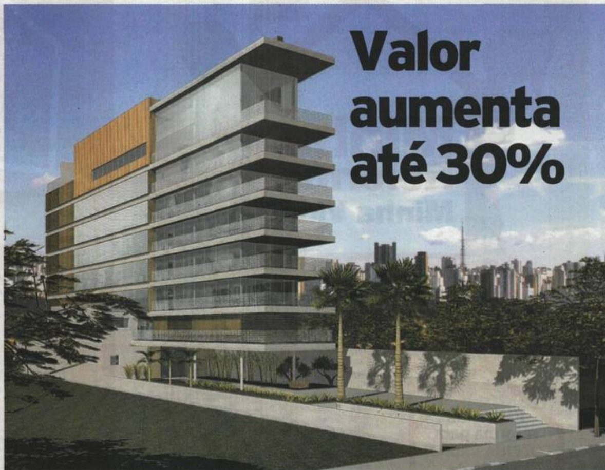
Prédio Panorama, nos Jardins, hoje: reforma mudou o uso de 'comercial' para 'residencial' para aproveitar valorização do Ibirapuera
