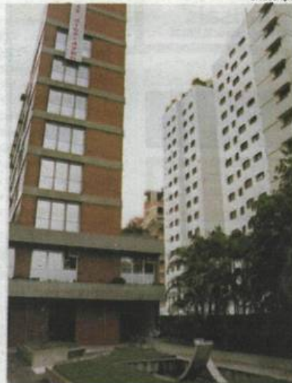
Prédio Panorama, nos Jardins, antes: deslocado do visual cada vez mais moderno do bairro
